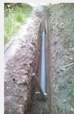
→ Châteauroux, renouvellement réseau aux Taxils
