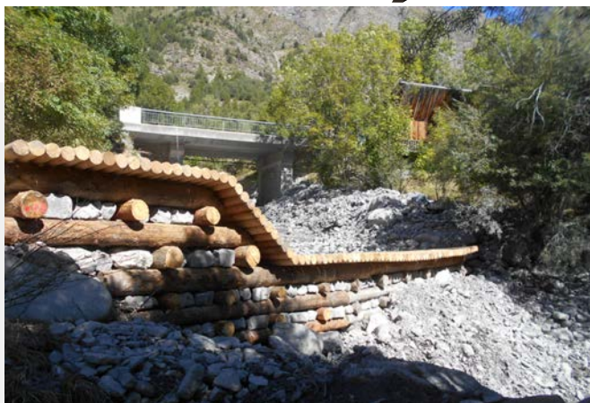
→ Crévoux, ouvrage bois combe Brunel Praveyral
